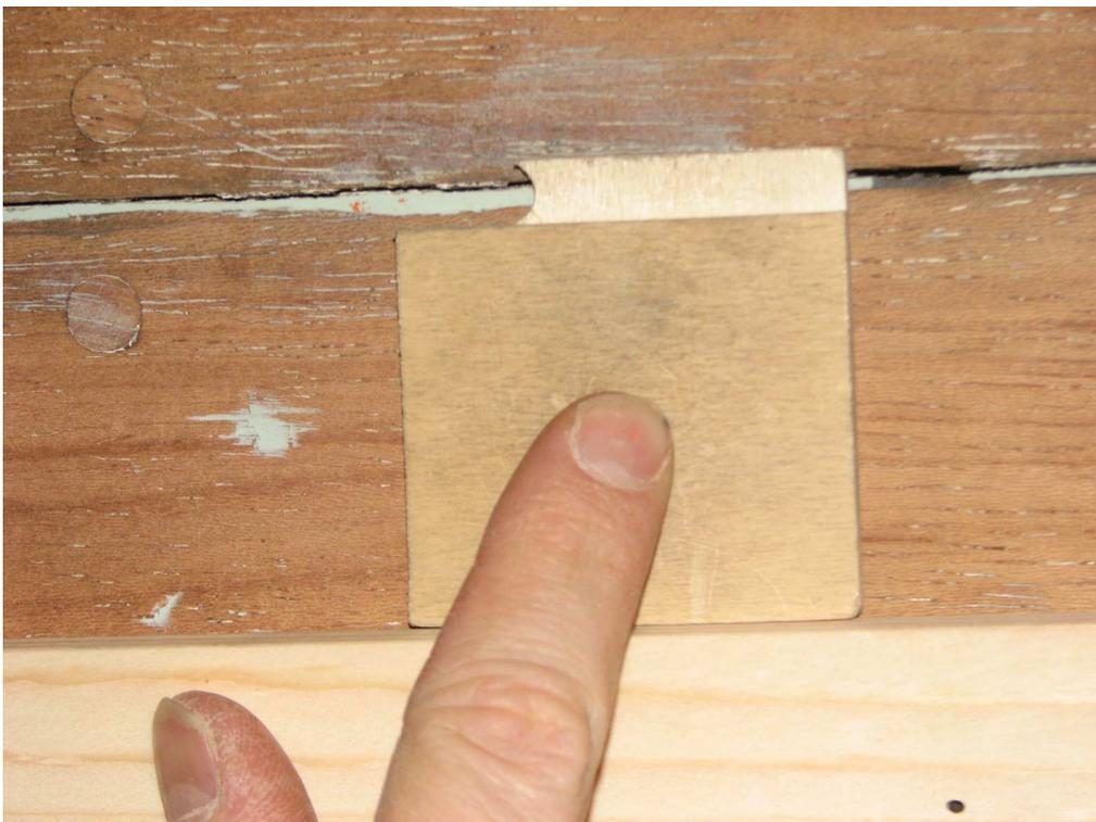
*Vérification de l'alignement du guide grâce au gabarit "maison" : La défonceuse va passer pile au bon endroit !*
